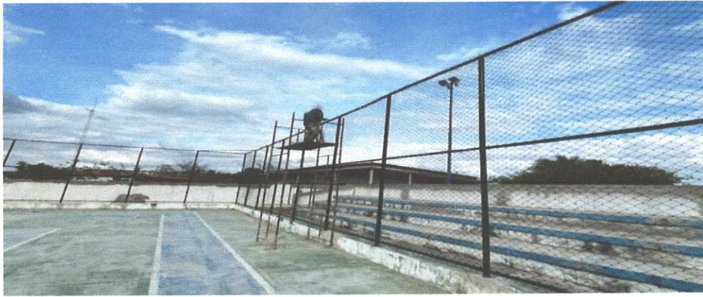
INSTALAÇÃO DE ALAMBRADOS
