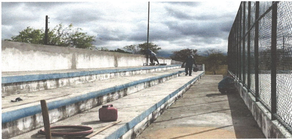
RECUPERAÇÃO DO PISO DA QUADRA POLIESPORTIVA
